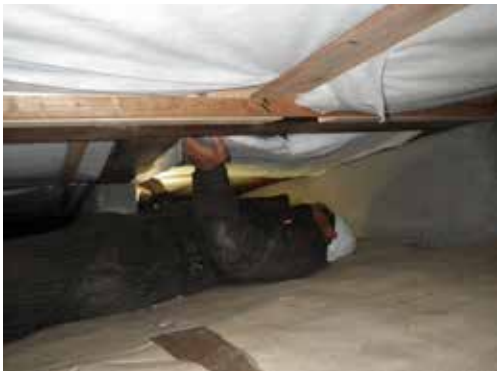
床下から断熱材を施工 (画像提供: 佐藤工務店)
