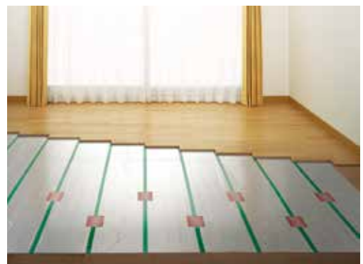
床板を張り、床暖房パネル・フローリングを施工 (画像提供: 東京ガス)
