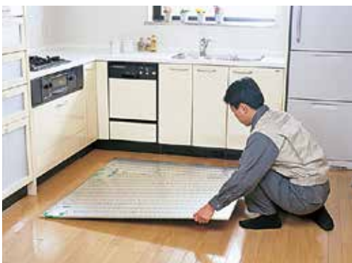
今の床の上に床暖房パネルを敷く (画像提供: 東邦ガス)
